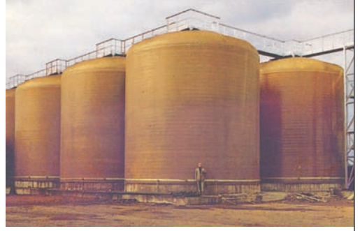
Vinil esterler bu tür yapıda genel olarak kullanılan reçinelerden biridir.
