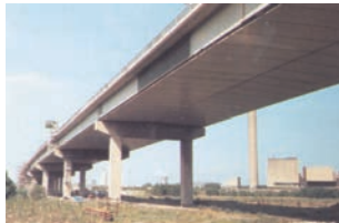
Köprü platform uygulamaları
